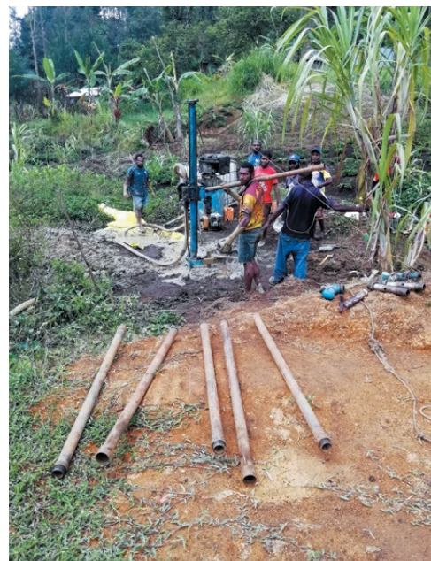
Prace przy odwiercie studni
