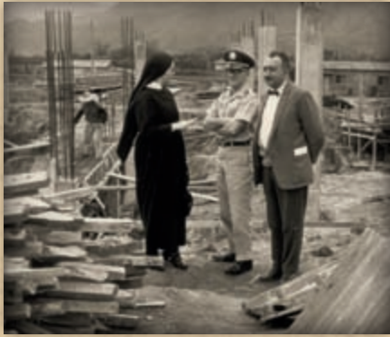
S. Rigoberta z zakonu salwatorianek, nadzorująca prace budowlane
