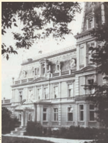
Dom Misyjny św. Stanisława Kostki w Chłudowie, 1938 r.
