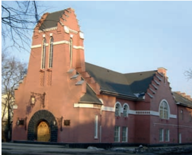
Budynek kościelny, w którym obecnie mieści się restauracja
