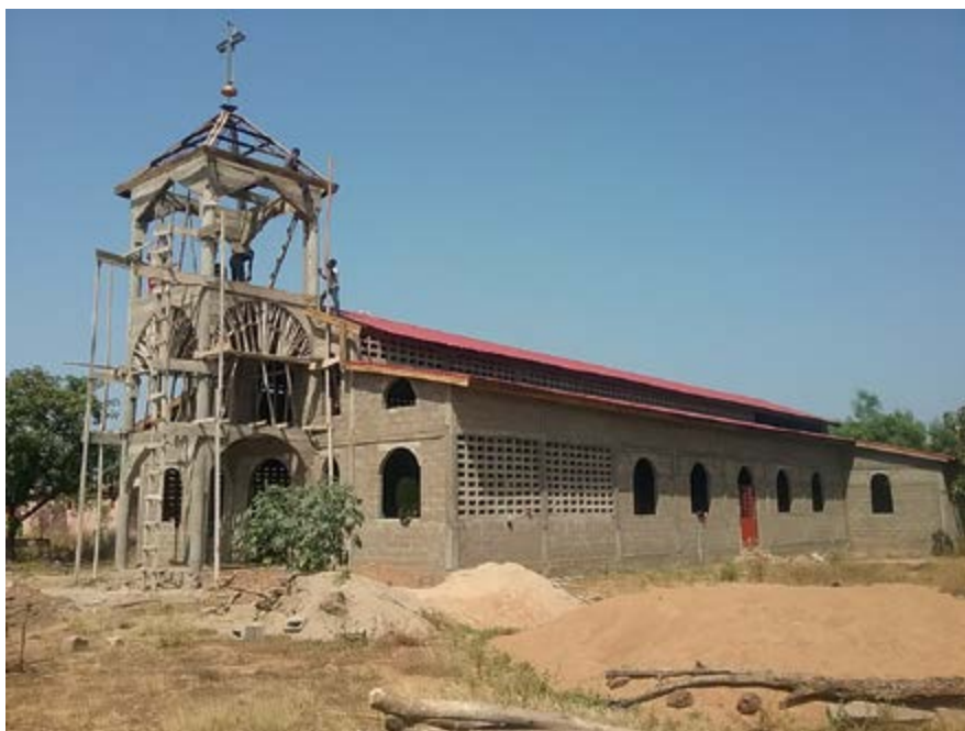
Budowany kościół św. Kizito w Kpatchilé, diecezja Kara w Togo
