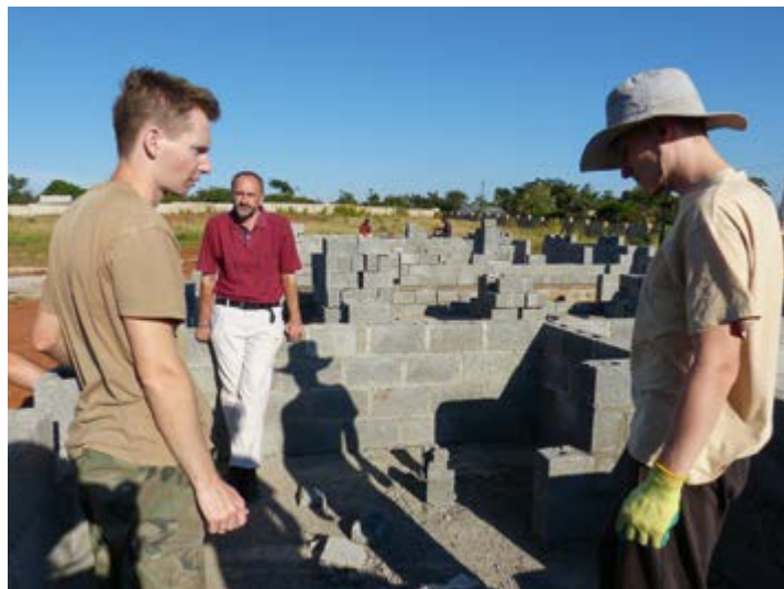
Z wolontariuszami na budowie przedszkola
